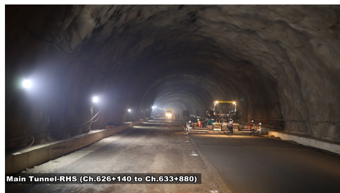
Illustrasjon 2: Et bilde av Samruddhi-tunnelen under bygging. Vanntåkesystemet er ikke synlig på bildet.
